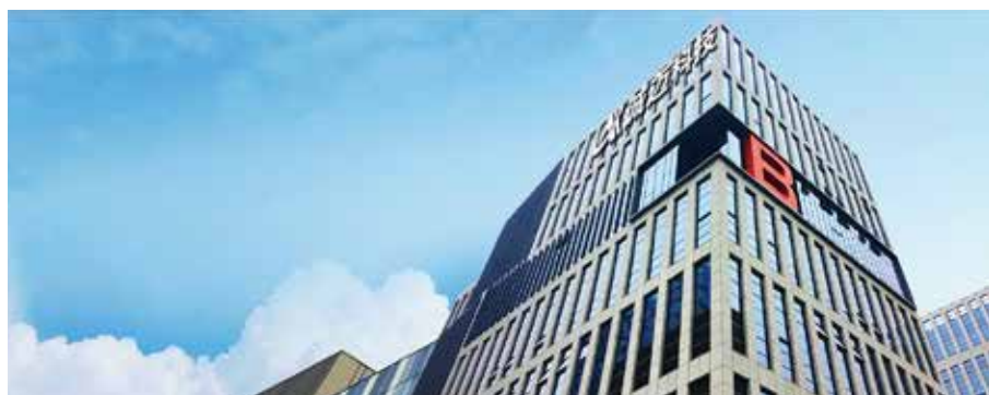
ARCHERMIND TECHNOLOGY 诚迈科技,南京密云总部大楼
