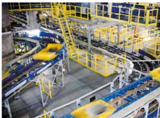
北京首都国际机场行李处理系统
